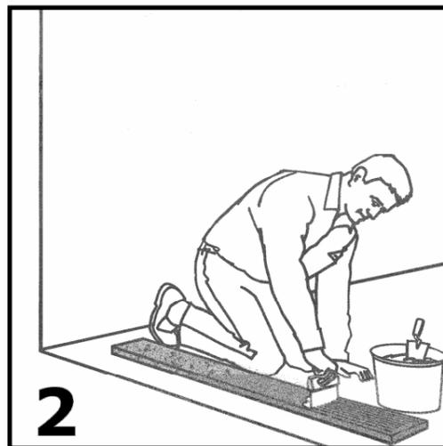
2 Apply tile adhesive or construction adhesive to the strip. Kleber oder Kitt auf der richtigen Seite der Leisten anbringen und gut andrücken. An den Seitenwänden und bei Türpfosten Endleisten verwenden. Etalez une colle pour carrelage ou utilisez le kit de montage pour les languettes. Tegelijm of montagekit op de rachsels aanbrengen.
